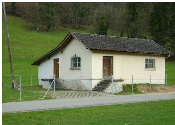
Station de pompage des Champs Fallat Capacité de pompage : 2 x 1000 ltr/min.
