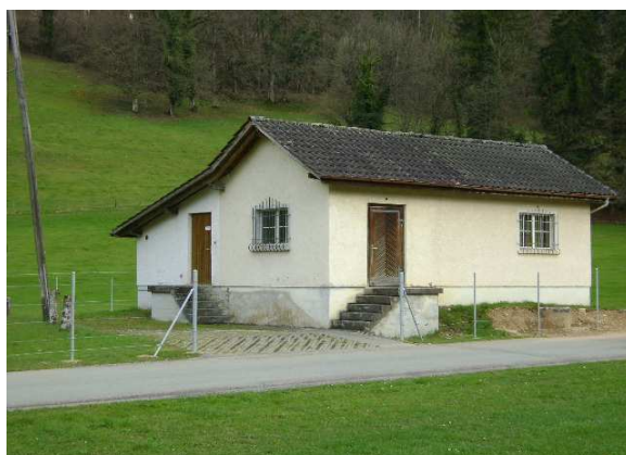
Station de pompage des Champs Fallat Capacité de pompage pour ces 4 villages : 2 x 380 ltr/min.
