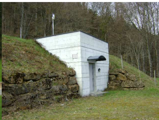
Réservoir de St-Ursanne Altitude : 540 m Capacité : 1000 m 3 Réserve incendie : 250 m 3
