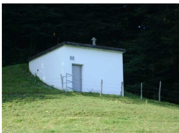
Réservoir du Chételat Altitude : 780 m. Capacité : 400 m 3 Réserve incendie : 150 m 3
